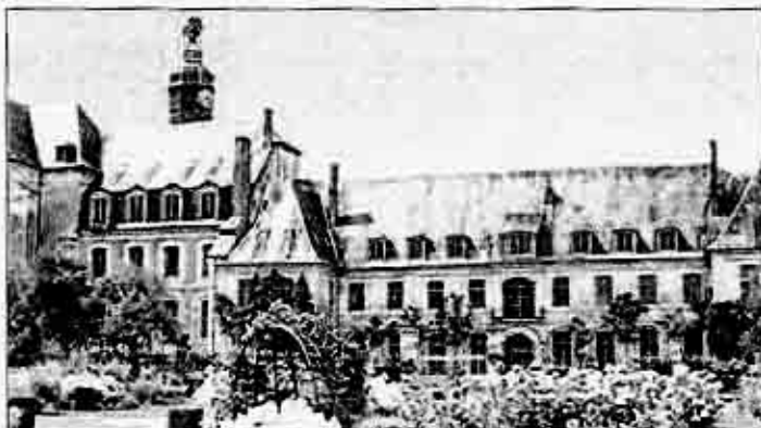
Le patrimoine de l'abbaye de Valloires nécessite en urgence 1,5 million d'euros d'investissement
