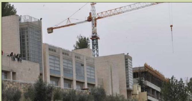
La nouvelle aile de l'Ecole Internationale pour l'Etude de la Shoah en construction
